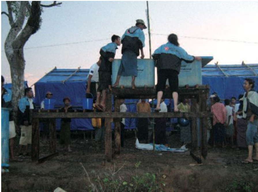
■ Installazione di serbatoi per l'acqua piovana
