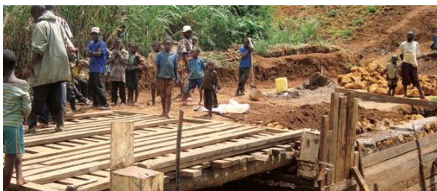
■ Manteniendo las vías de comunicación abiertas: construcción de una carretera en la República Democrática del Congo
