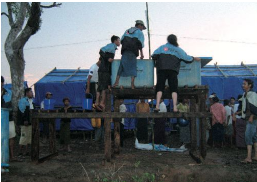
■ Montaje de tanques de agua
