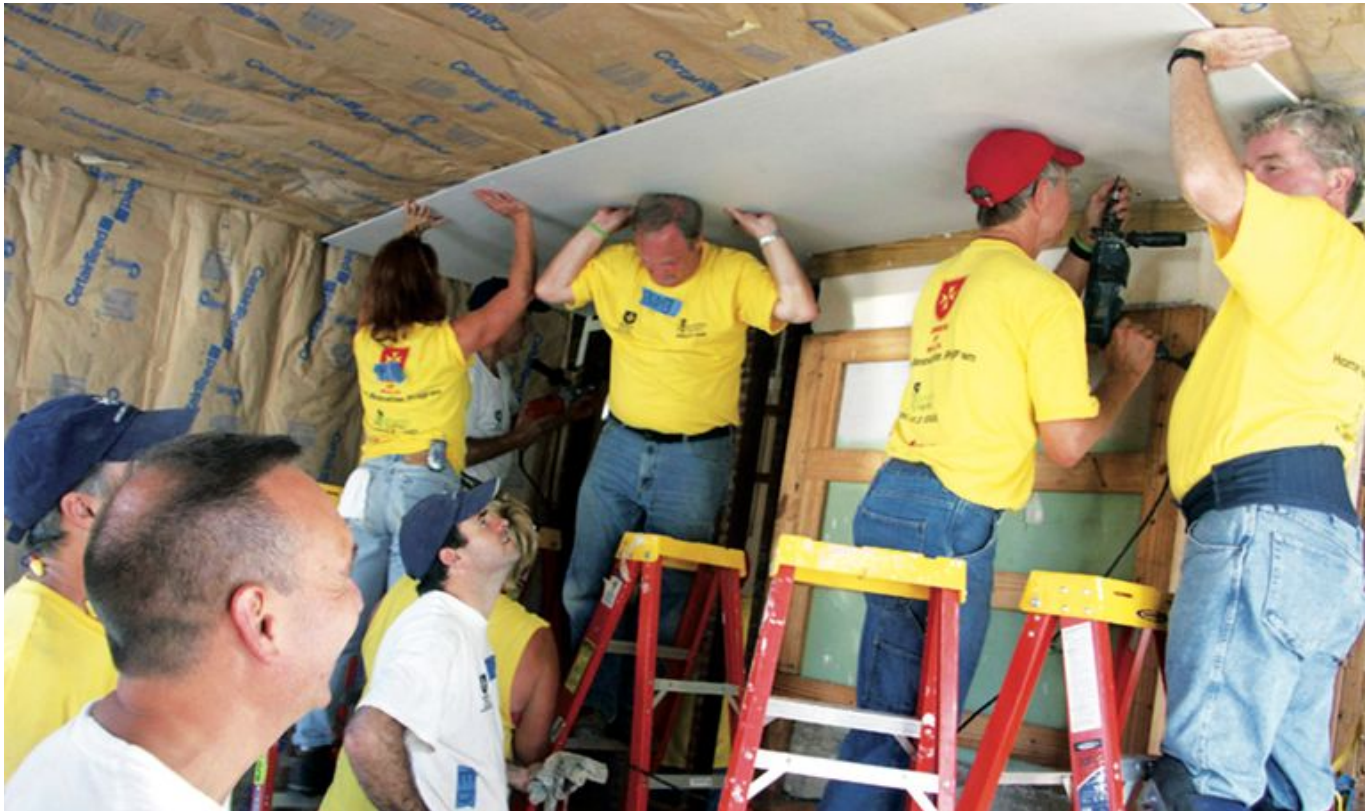
■ Der Wiederaufbau nach dem Hurrikan Katrina in New Orleans geht weiter: Freiwillige des Ordens bei der Arbeit
