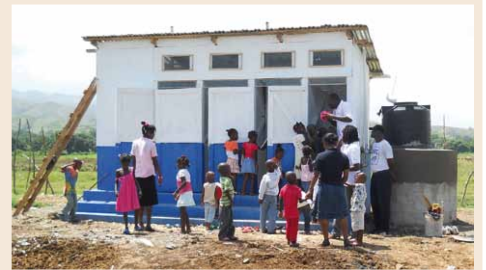
Neugierig werden die neuen Latrinen inspiziert. | Regards curieux : inspection des nouvelles latrines...
